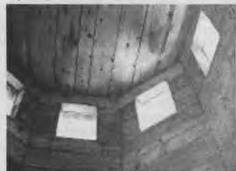
Потолок купальни источника
